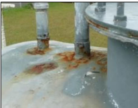
機械設備用燃料タンクの腐食
