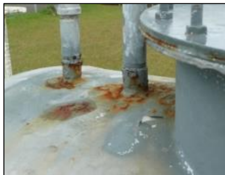
機械設備用燃料タンクの腐食
