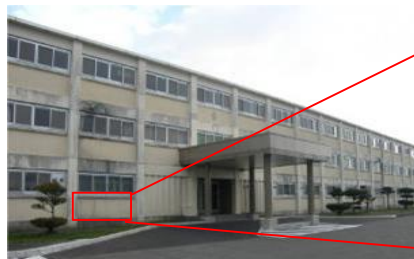
耐震性が不足する隊庁舎の建替
