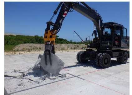
滑走路被害復旧器材
