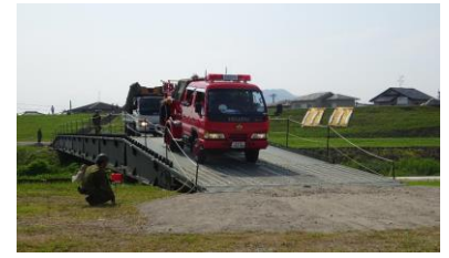
07式機動支援橋 (消防車の通過【防災訓練】)
