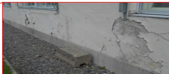
外壁のクラック
