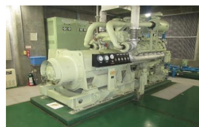
固定式自家発電機の整備
