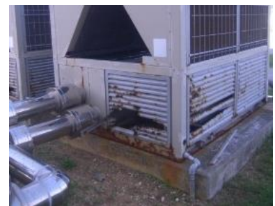
空調設備の更新
