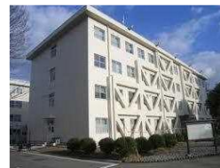
外部補強や内壁の増設による建物構造の強化 (イメージ)
